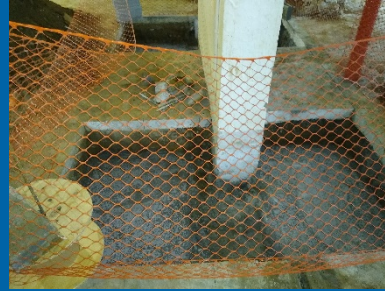
Pour Footings for Steel Columns in Cafeteria
